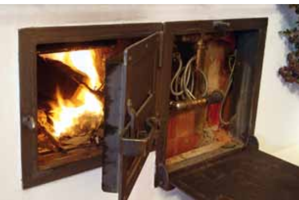
Karin Ecklmaier muss beim Musizieren keine klammen Finger fürchten. Ihr Ofen wird vom Herd in der Küche befeuert, der auch noch für Warmwasser sorgt. Die Technik ist im Backrohr eingebaut.
